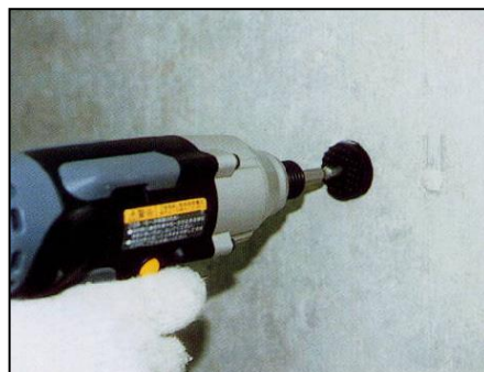
写真5. 電動ドライバーによるループボンドの取付け
