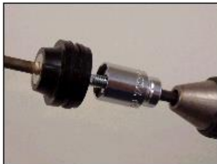
写真1. 全ネジ用ソケットによる セパレーターへの取付け
